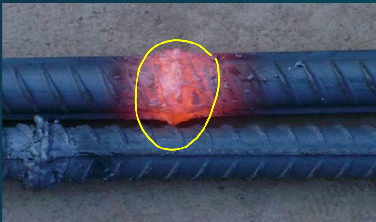
对焊接头近景
