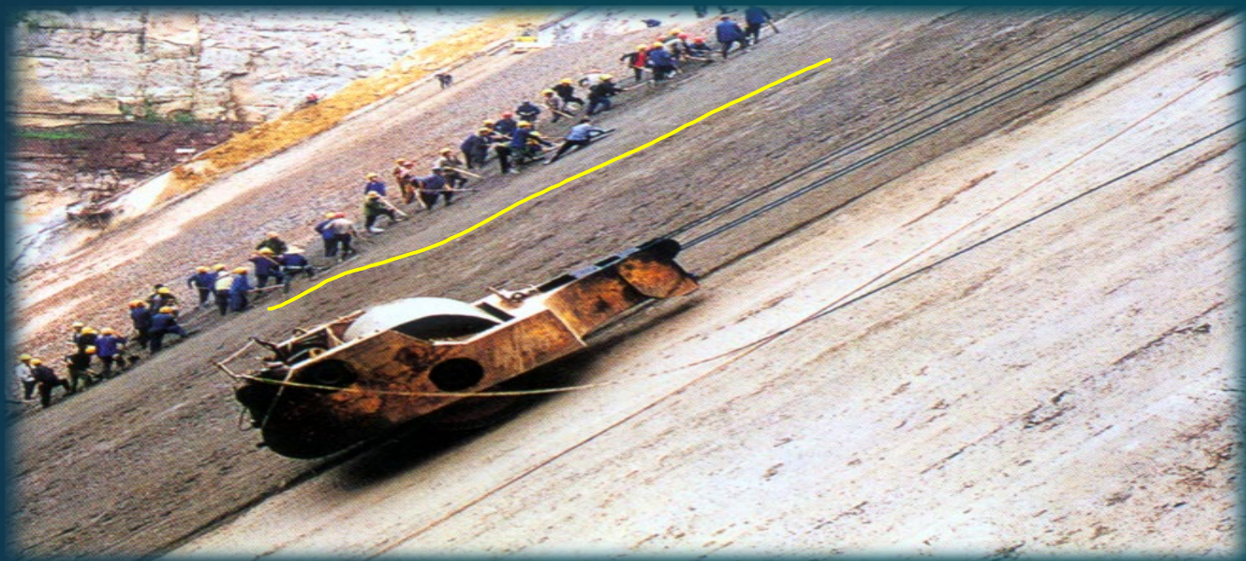
坝面固坡碾压
