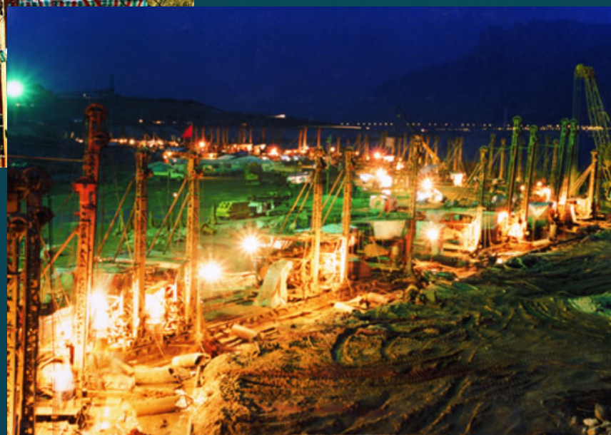
1997年大江截流 防渗墙施工（闭气）
