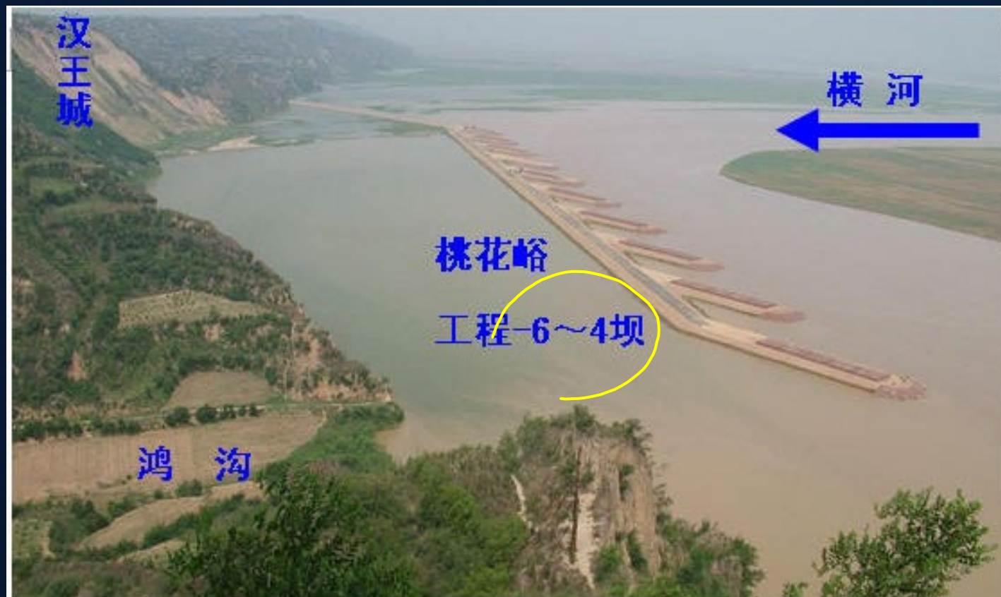
河道整治建筑物
