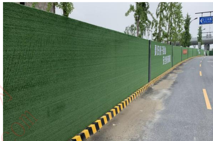
组合式彩（塑）钢板围挡实例图
