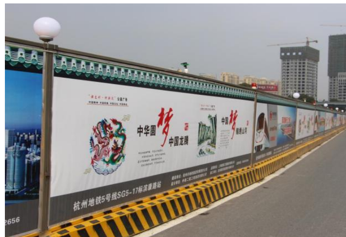
组合式彩（塑）钢板围挡实例图
