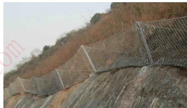
边坡防护网实例图
