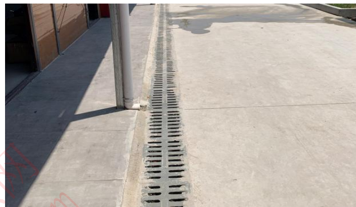
施工道路硬化及排水区实例图
