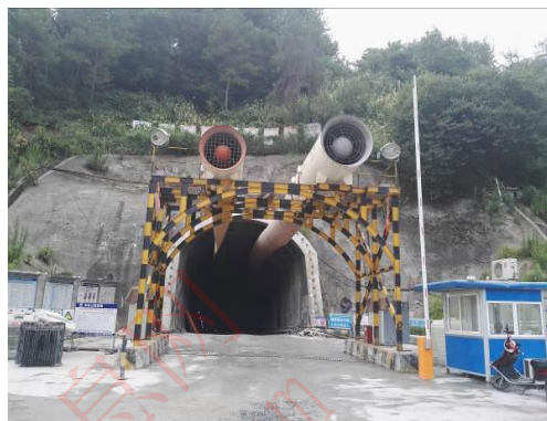
隧洞口防护实例图
