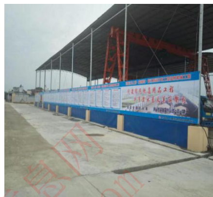
加工生产区场地硬化实例图
