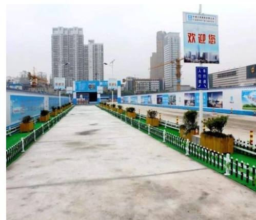
施工人员通道场地硬化实例图
