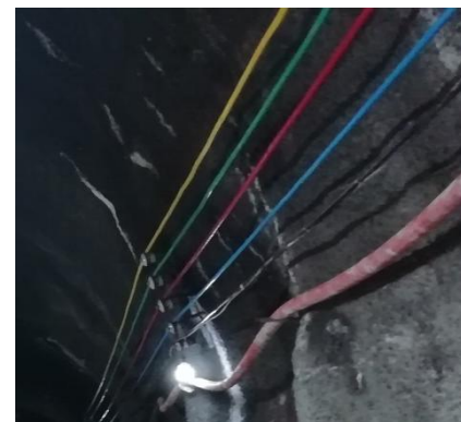
洞内电路敷设实例图
