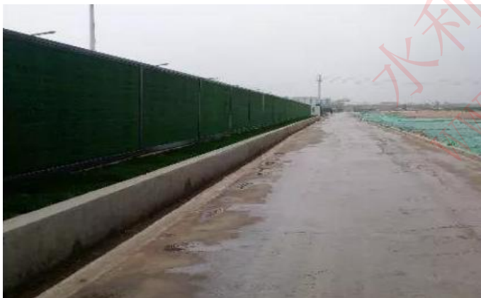
施工道路排水实例图
