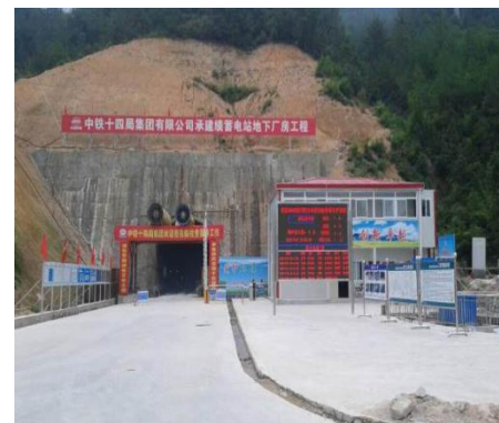
隧洞口防护实例图
