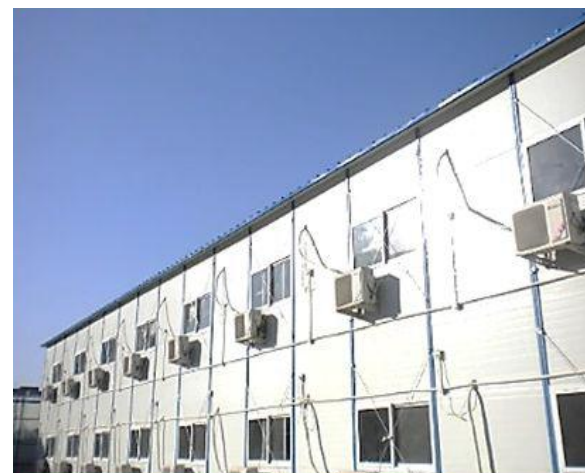
民工宿舍实例图(室外)
