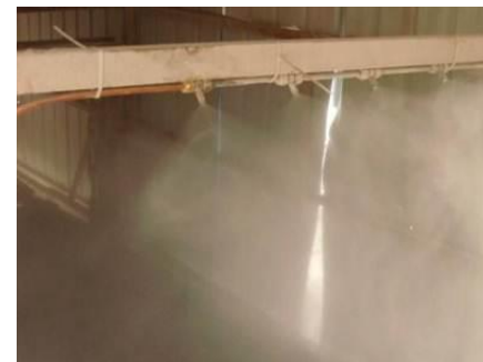
洒水降尘系统实例图
