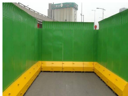
设置隔震防护罩实例图
