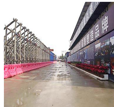
行车道场地硬化实例图
