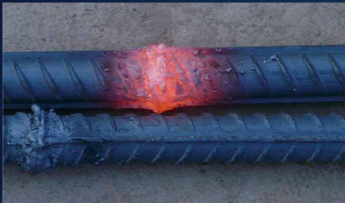
对焊接头近景
