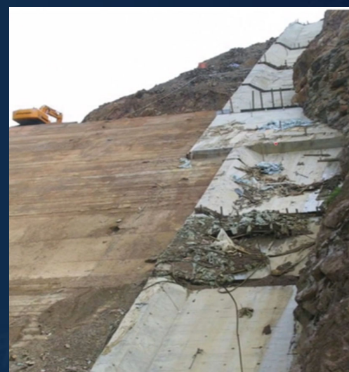
浇筑完成的趾板
