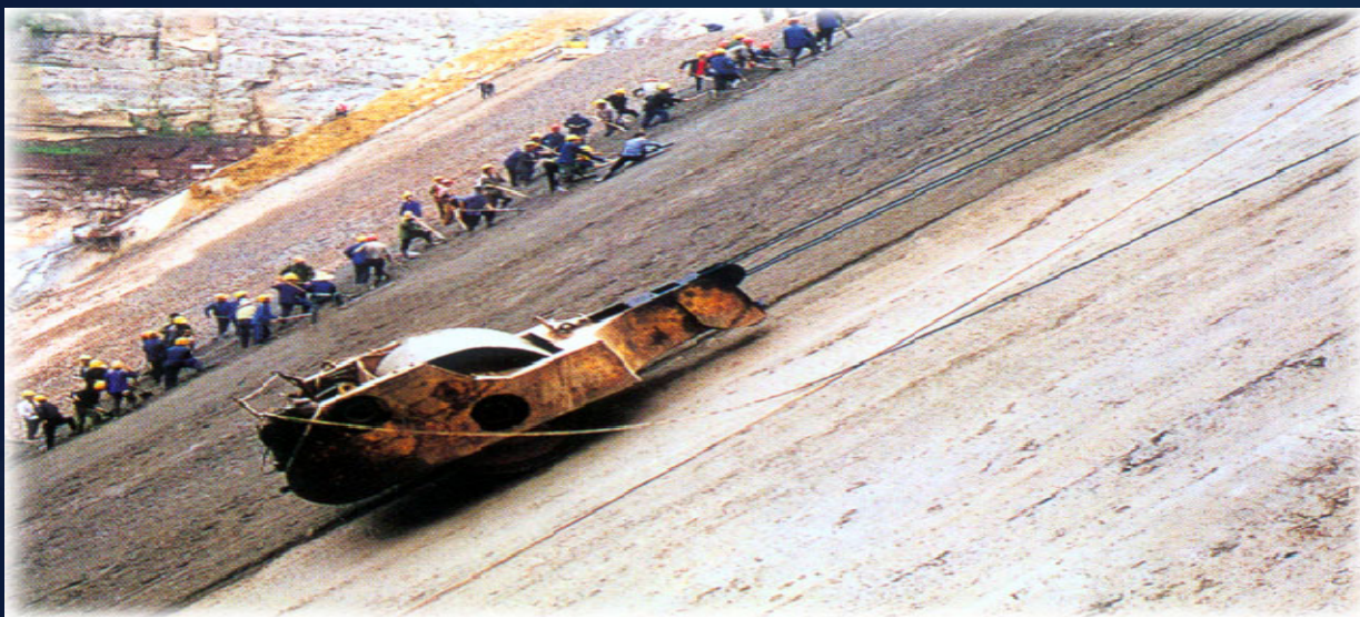
坝面固坡碾压
