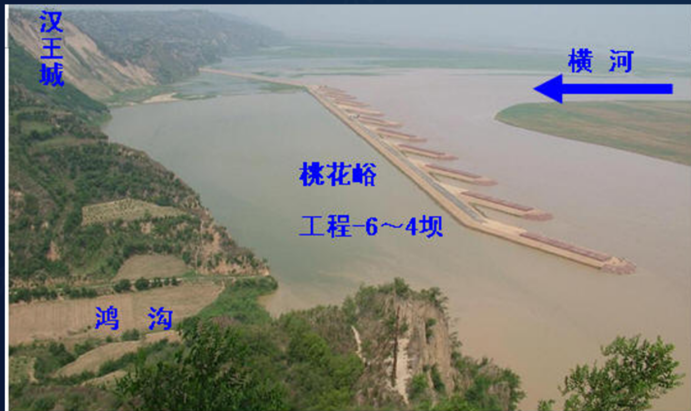
河道整治建筑物
