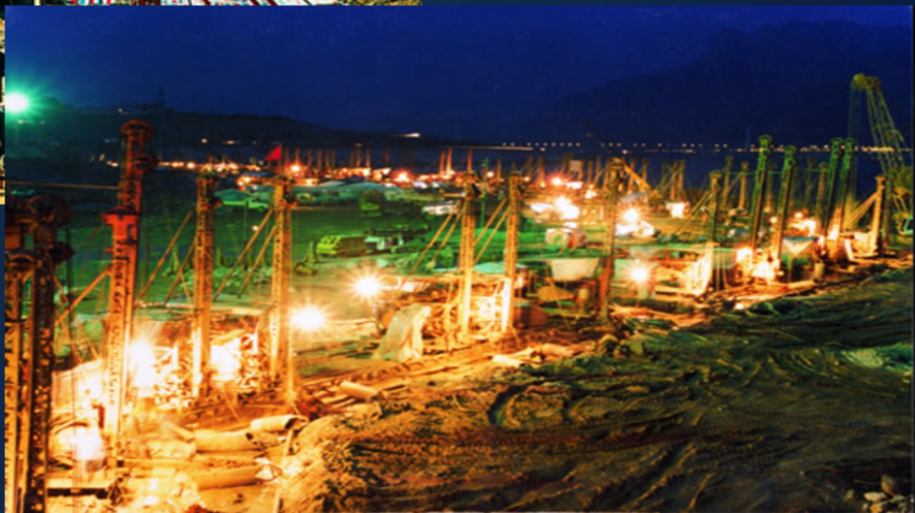
防渗墙施工 (闭气)
