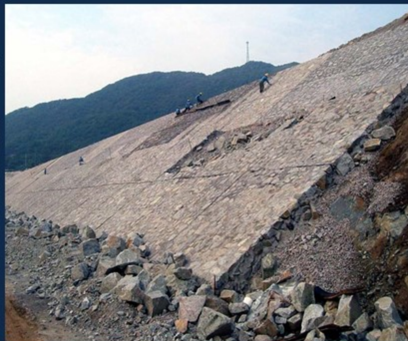
引水明渠浆砌石施工
