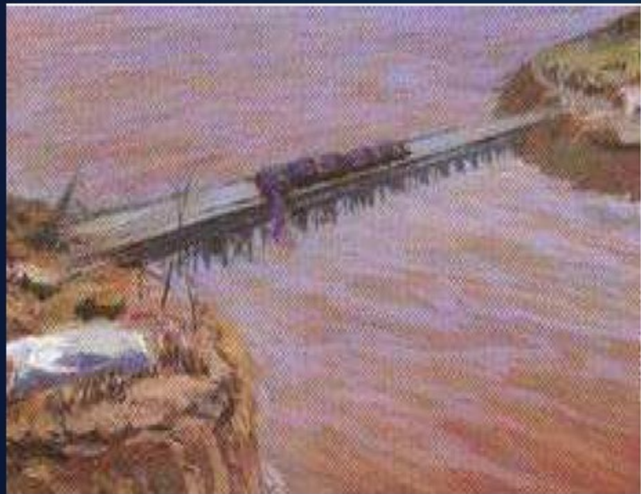
平堵法（龙口搭设浮桥，适用于软基河床）
